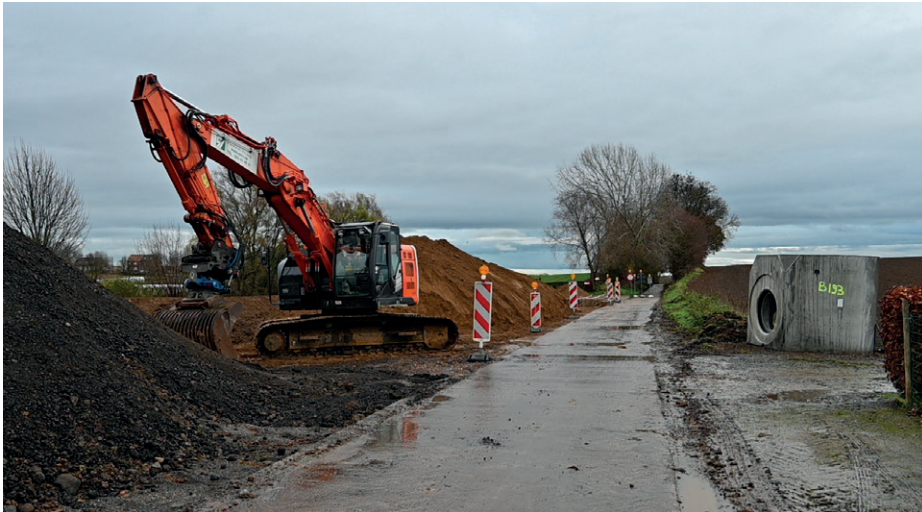
Werken aan het wachtbekken in de Tramstraat in Riemst.
